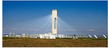
La central termosolar 11MW PS10 , funcionando en Sanlúcar la Mayor, España .
