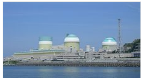
Central nuclear de Ikata , con tres reactores de agua a presión ( PWR ). La producción anual de energía eléctrica de este tipo de centrales se puede expresar en gigavatios-hora.
