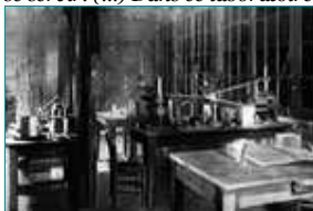
Le hangar de l'Ecole de physique et de chimie, vu de l'intérieur ©ACJC
